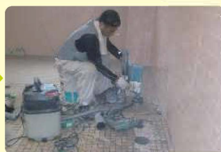
2 既存の器具、壁を取外し、配管工事をします。
